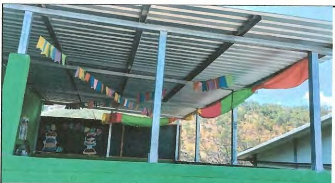
Foto 3: se realizará la instalación de ventanas para protegerá el aula de polvo.
