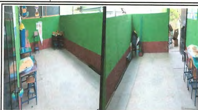
Foto 2: se realizará instalación de piso en el aula de párvulos.
